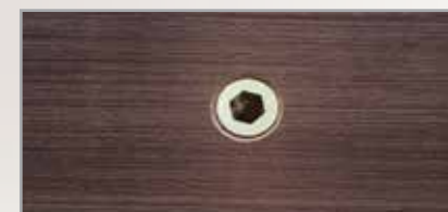
Sistema de fixação das mesas com buchas metálicas.
